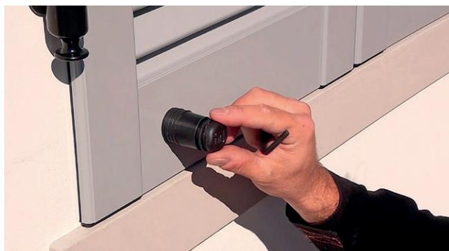
**17** - Concludere l'operazione con il montaggio del tappo in gomma.
