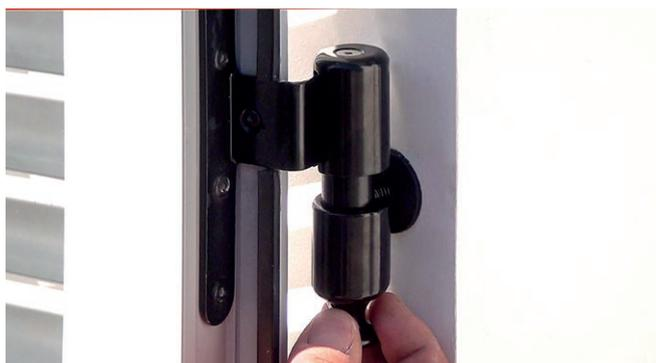
**12** - Sbloccare il cardine ed eseguire un'apertura dell'anta per provare il corretto funzionamento del meccanismo del cardine autobloccante.
