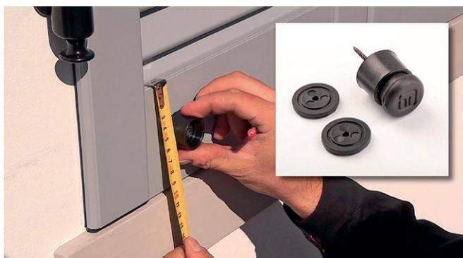
**14** - Definire il punto di foratura per il montaggio del tappo ammortizzatore.
