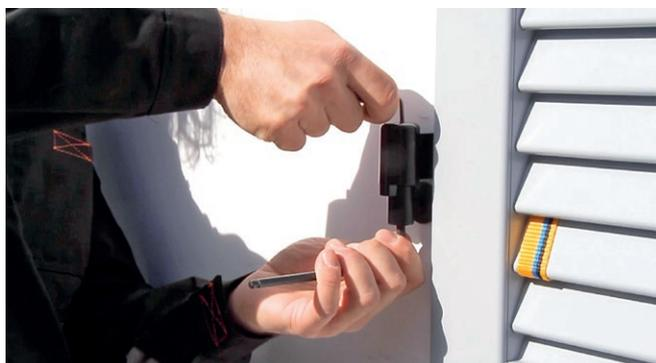
**10** - Applicare il blocco incontro del "785", dalla parte superiore della bandella, sull'apposita fessura verticale, corrispondente alla lama della bandella stessa e fissare il tutto con l'apposita vite.
