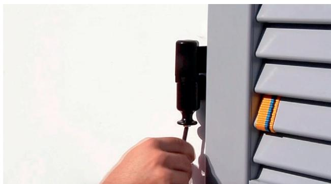
**11** - Applicare il blocco base del cardine "785" dalla parte inferiore della pipa a muro. Fissare quest'ultimo con vite e molla in dotazione.
