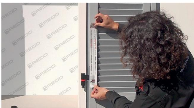
**20** - Applicare l'adesivo in dotazione in corrispondenza alla posizione del cardine autobloccante: inferiore per finestre e centrale per porte finestre.
