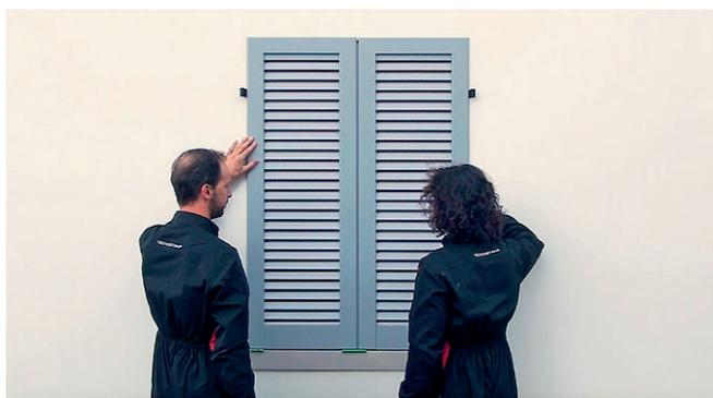
Posizionare l'anta completa di bandelle precedentemente montate nella posizione finale.
