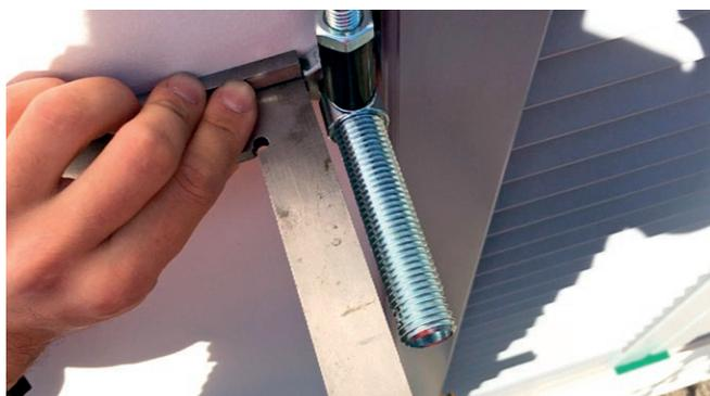
**2** - Verificare il corretto allineamento della dima che dovrà essere **esattamente a 90° rispetto al muro** (Se non è a 90° il cardine non funziona).
