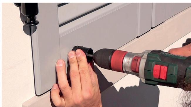
**15** - Procedere con il preforo dell'anta e fissare la base del tappo con l'apposita vite.
