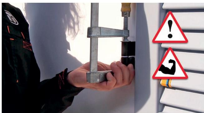
8 - Utilizzare un morsetto per inserire il perno dalla parte superiore della bandella. **Attenzione! È prevista un'azione forzata data dall'interferenza meccanica tra perno e foro bandella.**
